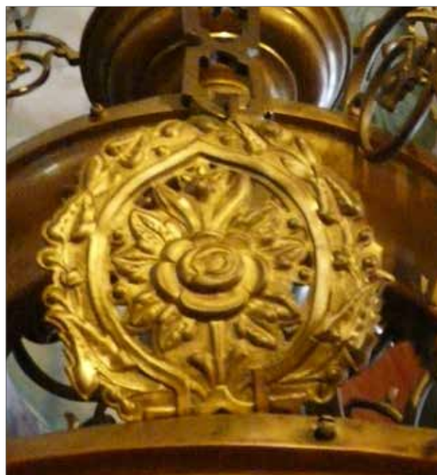
Илл. 10. Букет с розой в картуше - круглый крупный рельефный прорезной декор, установленный сверху нижнего обода, таких декоров три, они помещены в местах крепления цепи.
