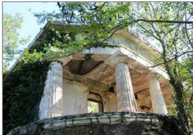
Илл. 3. Руины господского дома в бывшем имении Суворино в урочище Агрива. Северо-западный угол и фрагмент колоннады западного фасада. Фото В. В. Бондаря, 2020 г.
