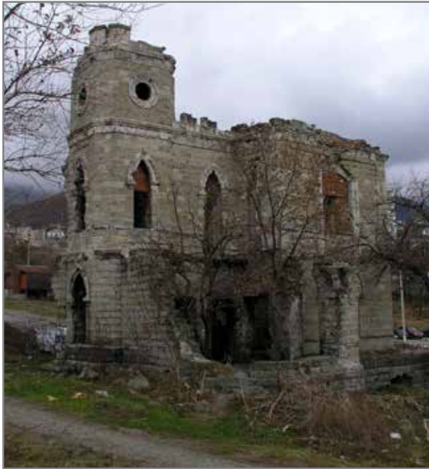
Илл. 1. Руины господского дома в бывшей усадьбе князя Б. Б. Голицына на восточной окраине Новороссийска. Вид с юго-запада. Фото В. В. Бондаря, 2015 г.
