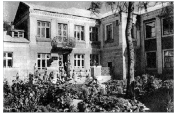
Илл. 2. Детский сад трикотажной фабрики им. Розы Люксембург. 1937 г. В настоящее время объект культурного наследия регионального значения, в котором расположена экспозиция Сергиево-Посадского музея-заповедника, посвященная истории города.
