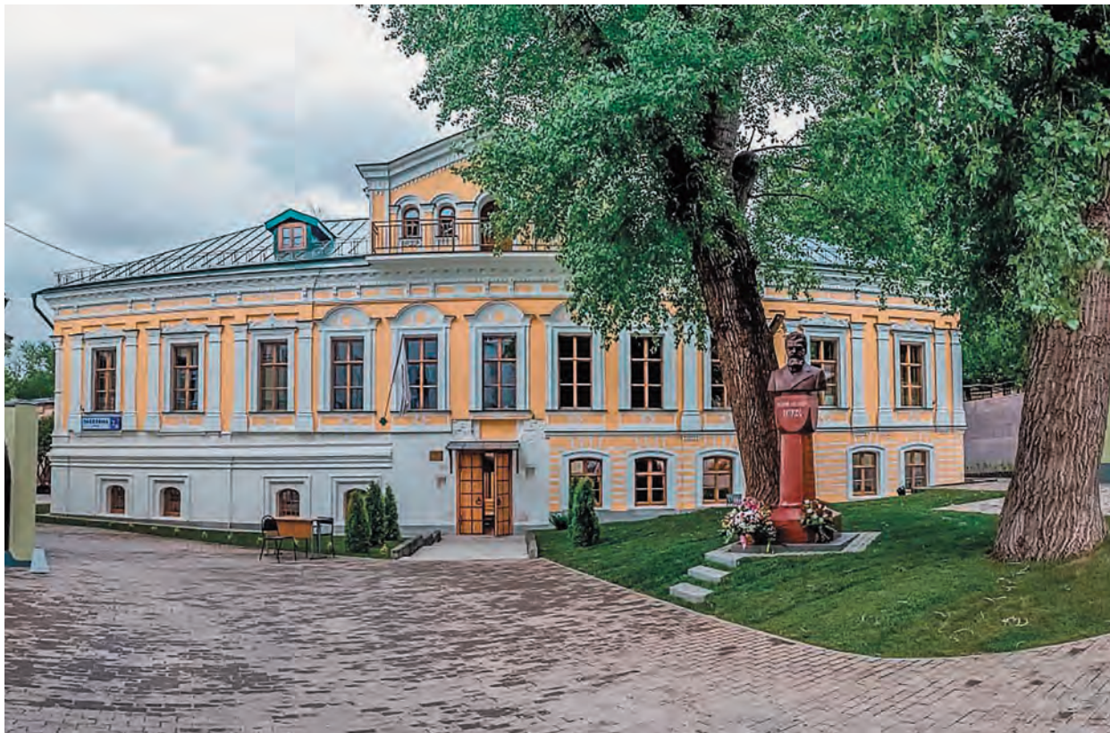
Современное здание центра ИППО в Москве на улице Забелина
